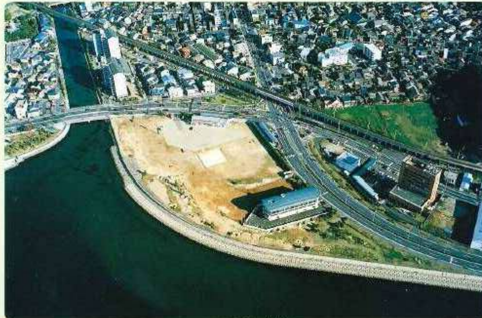
【工事着手前の状況】
